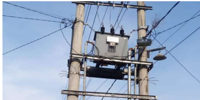
Gambar 14. Pemasangan alat deteksi
