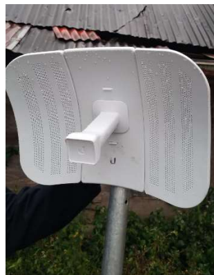
Gambar 7. Pemasangan Antenna LiteBeam M5 pada Tiang
