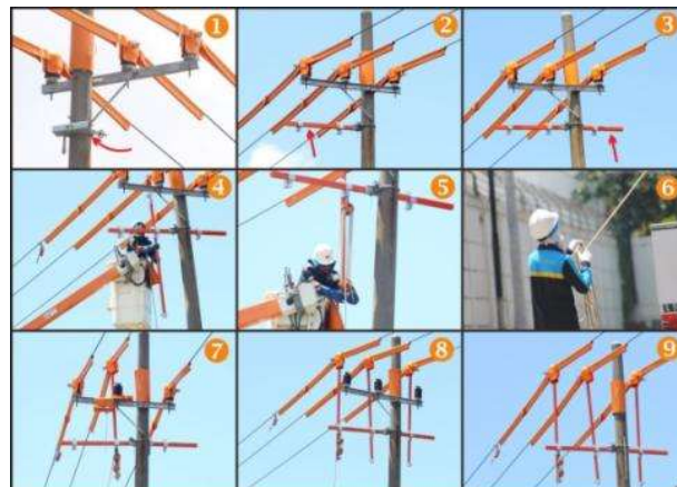
Gambar 7. Tahap-tahap pemasangan Temporary Cross Arm Support Insulator dengan metode Sentuh Langsung
