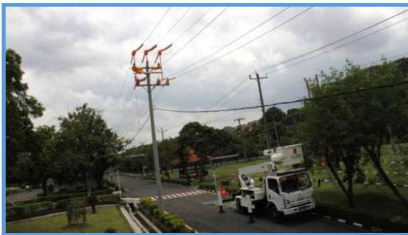
Gambar 8. Pemasangan Peralatan Inovasi pada Jaringan SUTM 20 kV PLN UPDL Semarang dengan Metode Sentuh Langsung.
