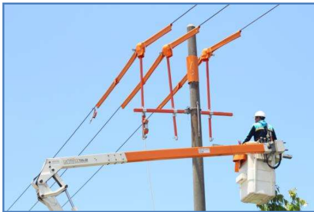
Gambar 9. Pemasangan Peralatan Inovasi pada Jaringan SUTM 20 kV PLN Area Surabaya Selatan dengan Metode Sentuh Langsung
