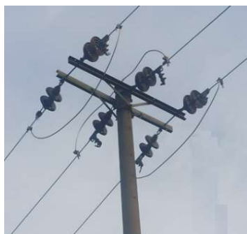
Gambar 4. Konstruksi Double Dead End
