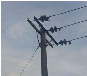
Gambar 3. Konstruksi Dead End
