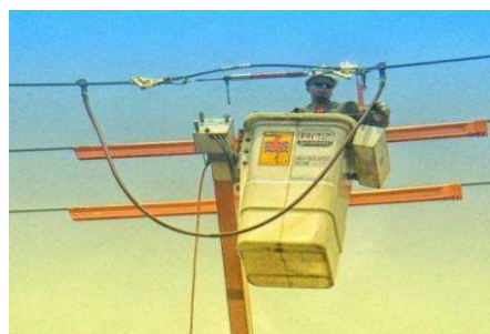
Gambar 14. Pemasangan Cowok 3 in 1 pada kawat rantas
