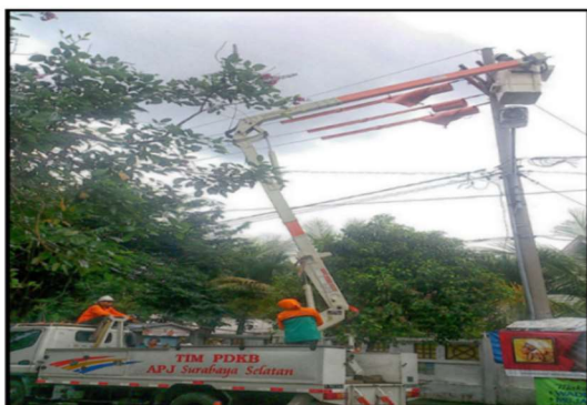
Gambar 19. Implementasi pada Konstruksi Single Dead End di PLN Area Surabaya Selatan
