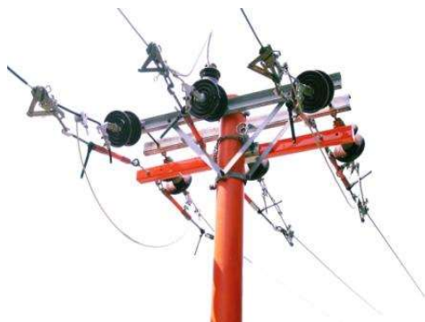
Gambar 11. Pemasangan Cowok 3 in 1 pada konstruksi Double Dead End
