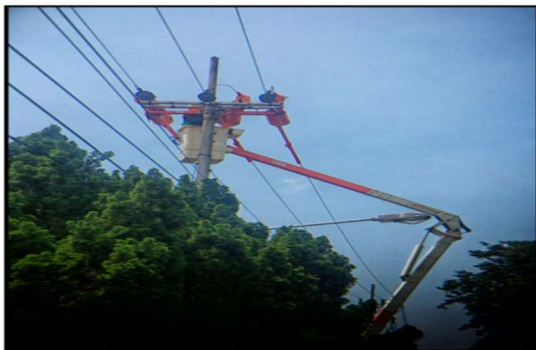
Gambar 18. Implementasi pada Konstruksi Double Dead End di PLN Area Surabaya Selatan
